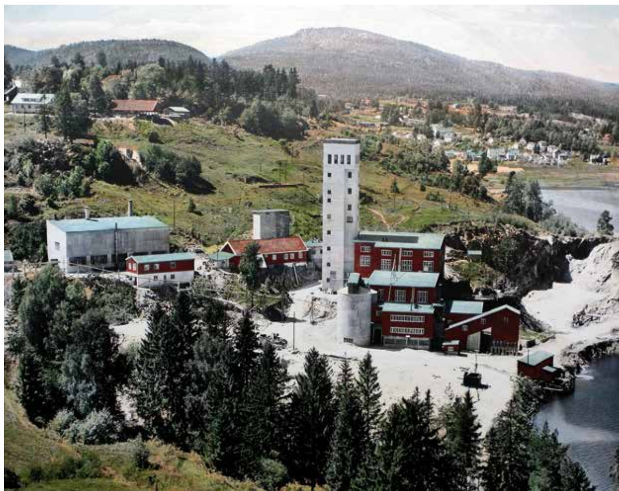
A/S Norsk Bergverks gruveanlegg ved Norsjø
